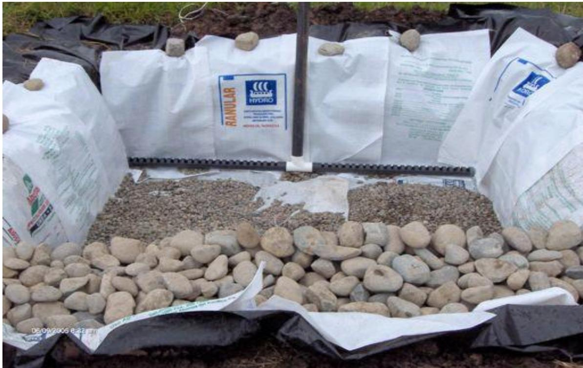
Una vez colocada la primera capa de piedra bolón, debe asegurarse, comenzar la capa filtrante intermedia para que permita estabilidad y no se derrumbe.
