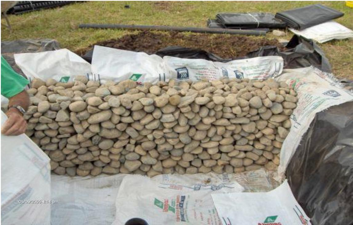
La colocación de los sacos sobre el plástico es necesaria para evitar que el material filtrante (piedra bolón) desgarre el plástico. El material filtrante se colocara de manera manual, considerando su ancho, calculado en la memoria.
