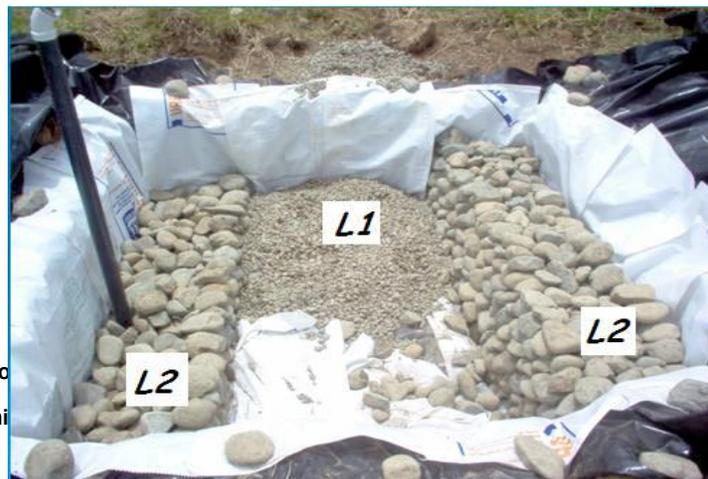
Juan verifica si la construcción queda conforme al esquema y puede verse la ubicación de la tubería de entrada y salida dentro de la biojardinera
